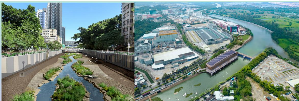
元朗區的地勢平坦，市中心的主要排洪設施為已建成逾50年的元朗明渠。元朗明渠收集元朗新市鎮、興建中的元朗南發展區及上游集水區的雨水，並將其排放至山貝河，再流出后海灣。因受持續土地發展和氣候變化影響，元朗區的水浸風險有所上升。渠務署過往一直致力在元朗區內推展雨水排放系統改善計劃，以減低元朗區水浸的風險，但近年超強颱風和極端天氣每趨頻繁，再加上因后海灣海水倒灌及極端暴雨狀況，元朗市中心地區的水浸風險將會明顯增高。為提升排洪能力，以及更有效管控元朗區的水浸風險，渠務署在元朗明渠下游，毗鄰元朗工業區的位置推展防洪壩計劃。防洪壩計劃包括在元朗明渠建造自動防洪屏障、雨水泵房、總控制中心及相關機電設施。防洪壩是根據預測的降雨量及潮水高度，以及實時監察的明渠水位高度等因素運作。在完成工程後，元朗市中心的水浸風險將得以紓緩。
